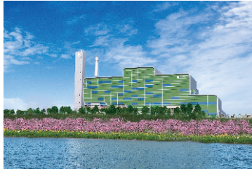
安徽六安环保发电厂(1200吨/天) Anhui Lu' an WTE Plant (1200 t/d)
